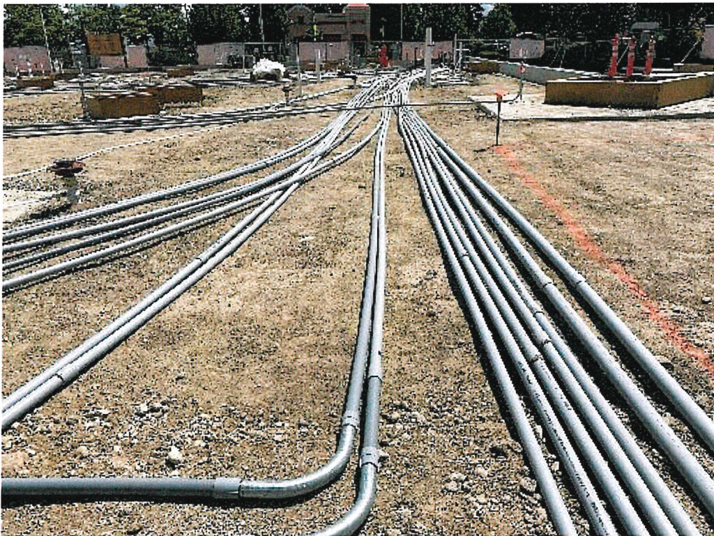
Underslab Electrical Conduit
