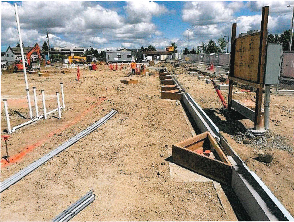
Underslab Electrical Conduit
