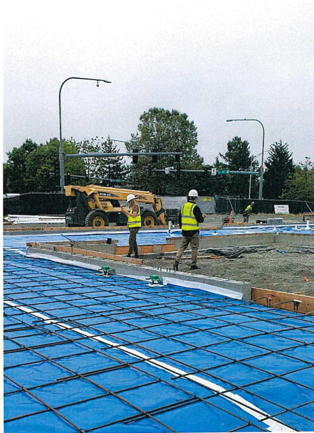
Vapor barrier prep for slab on grade pour
