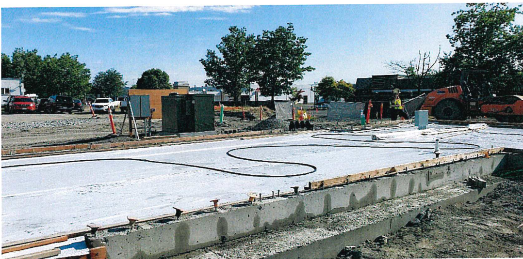
First slab on grade pour
